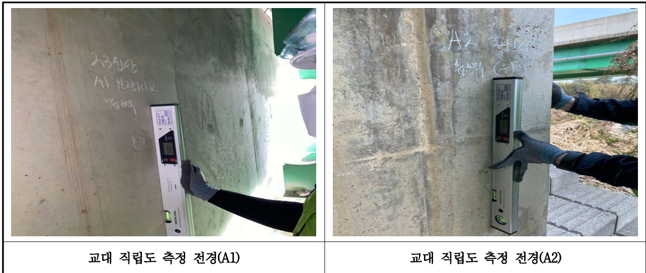
【그림 3.8】 교대 변위(직립도) 측정 모식도 및 전경(계속)
