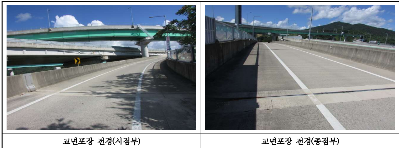
【그림 3.15】 교면포장 전경 및 상세도(계속)
