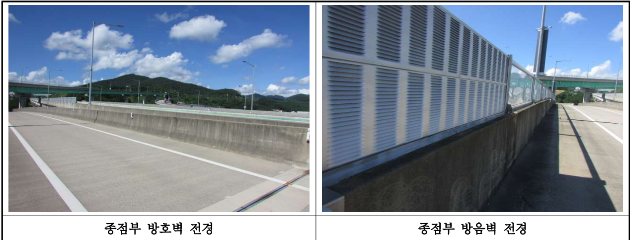
【사진 3.24】 난간 및 연석(방호벽) 전경(계속)
