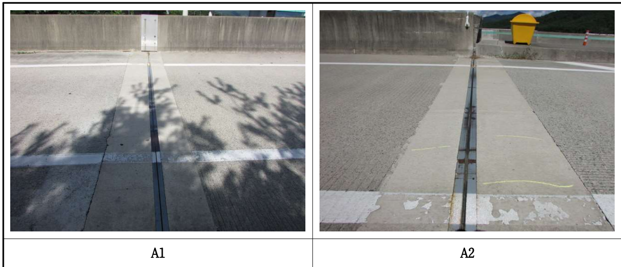
【사진 3.19】 신축이음장치 전경
