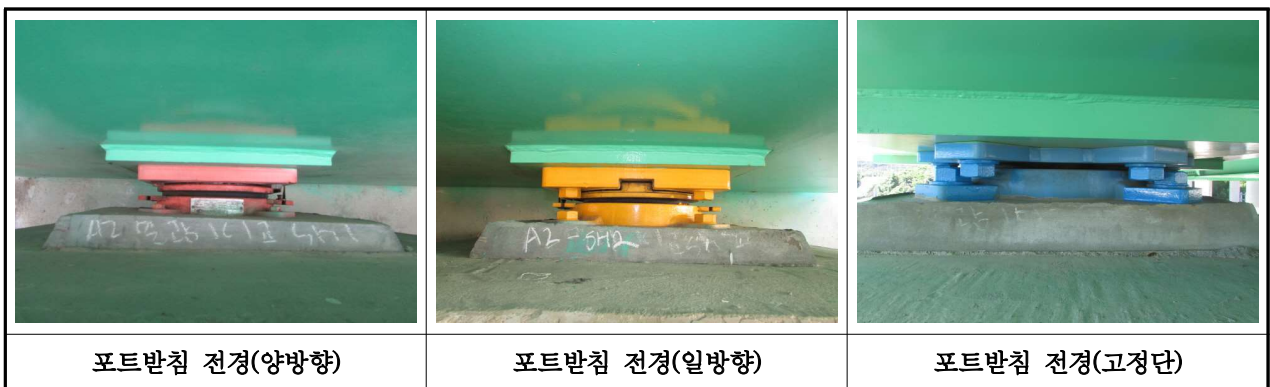
【사진 3.16】 교량받침 설치전경
