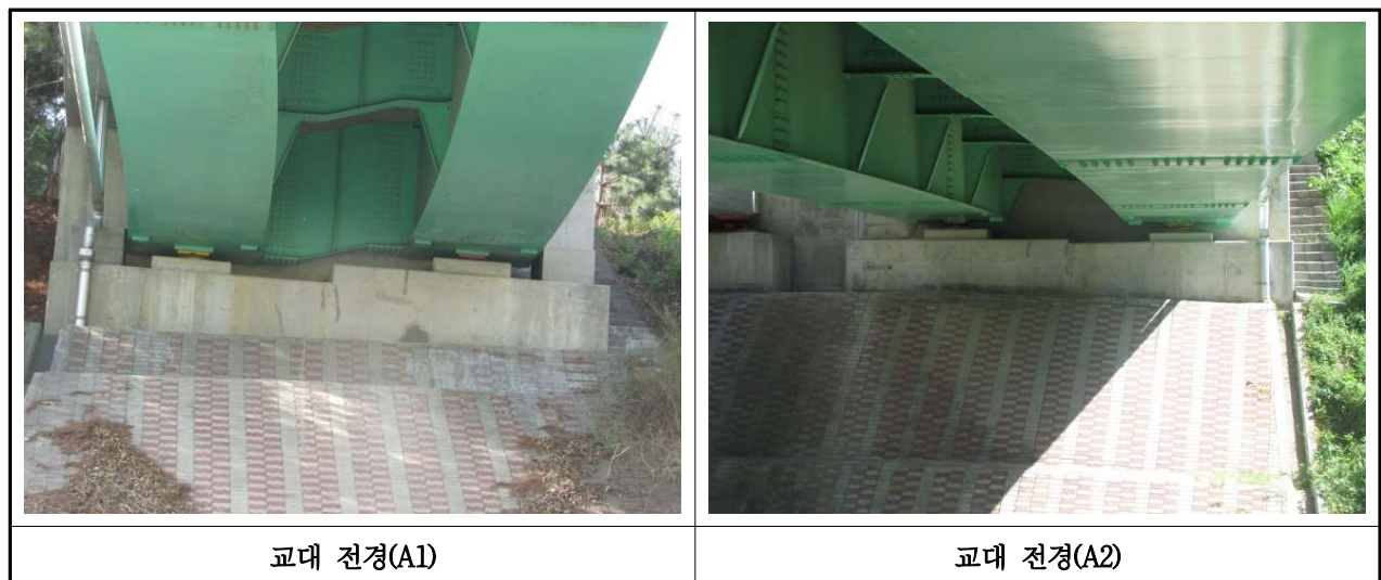
【사진 3.11】 교대 전경
