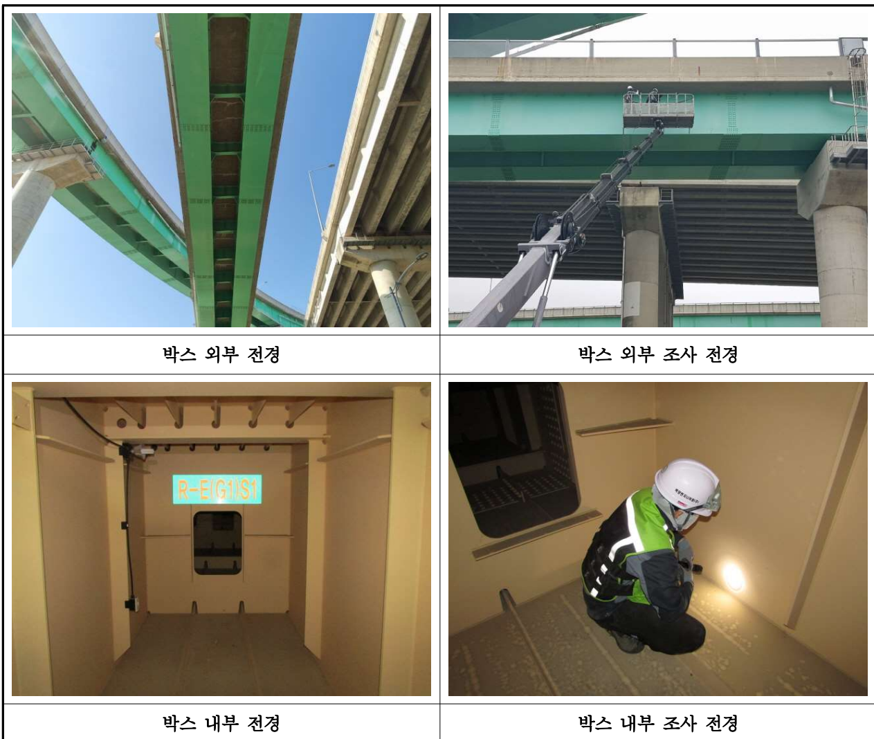
【사진 3.6】 강박스 거더 전경
