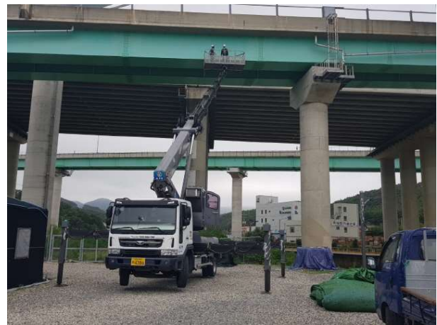
고소작업차를 이용한 현장조사
