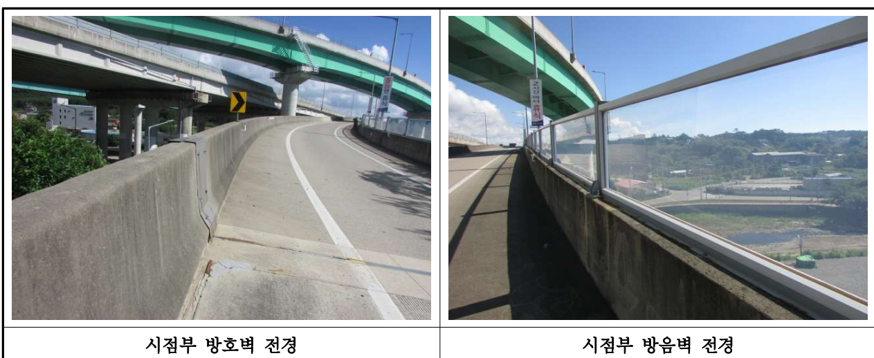
【사진 3.24】 난간 및 연석(방호벽) 전경
