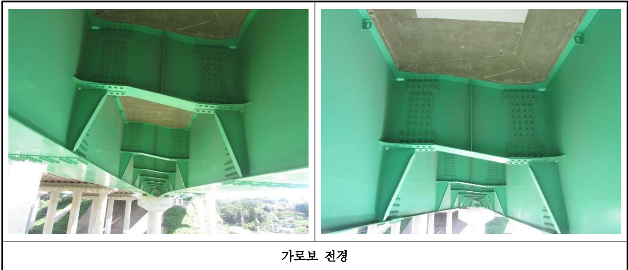
【사진 3.9】 2차부재(가로보) 전경
